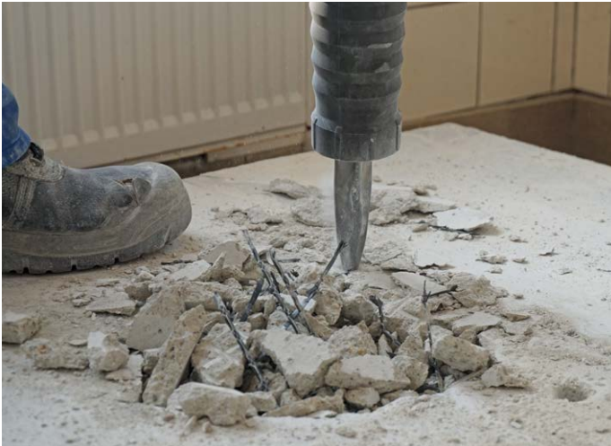
Manueller Abbruch mit dem Stemmerhammer.
