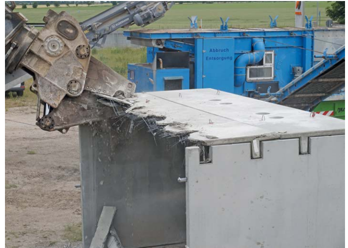
Maschineller Abbruch mit Abbruchzange (Abbruchverfahren Pressschneiden).
