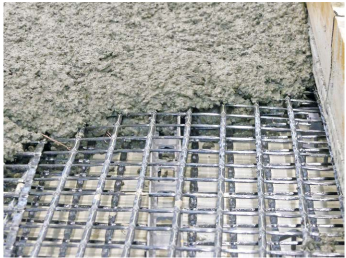
Betonage einer Fertigteilwand mit Carbonbewehrung (Beton C50/60, Größtkorn 8 mm).
