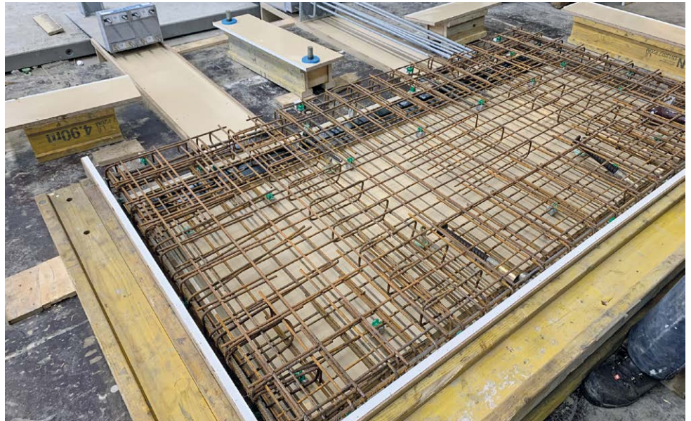
Der Schöck Isokorb Typ S für die thermische Trennung im Stahlbau wird bereits im Fertigteilwerk eingebaut.
