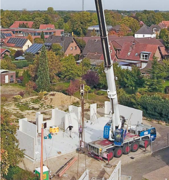
Montage der Betonfertigteile.
