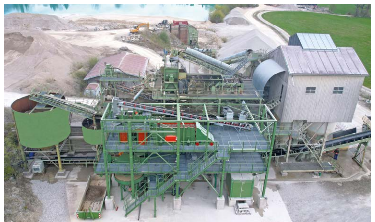
Kombination Kieswerk und Bodenaufbereitungsanlage.
